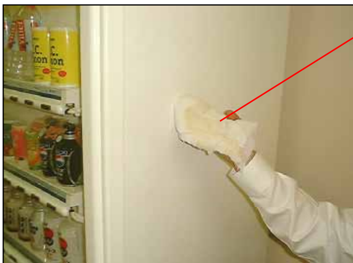
施工完了日設置の新自動販売機
